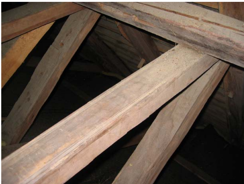
Hanebjelke med dekorative profiler langs oversiden. Foto: OS 10
