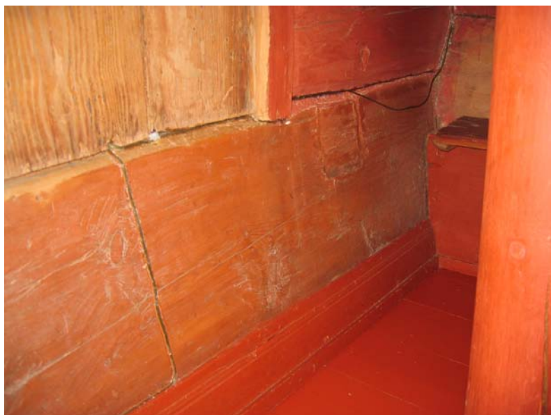
Skipets østre svill, sett mot sør-øst. Innfesting av korets svill i den søndre enden. Foto: OS 10
