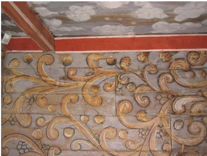
Vestre del av korets nordvegg, sett mot nord, skjøtte veggstokker og gjennomgående raftestokk. Foto: OS 10
