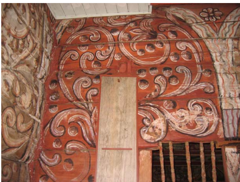
Nordre del av skipets østvegg, sett mot øst med gjennomgående raftestokk fra korets nordvegg. Foto: OS 10
