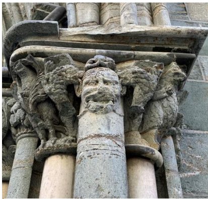
Figur 9: Oktagonportal fra Nidarosdomen, detalj: høyre kapitel. Eget foto.
