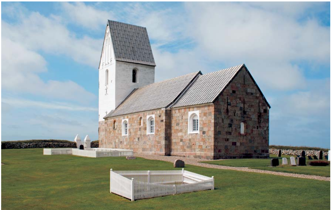
Fig. 13. Ydre set fra sydøst. Foto Hugo Johannsen 2012. – Äußeres aus Südosten.
