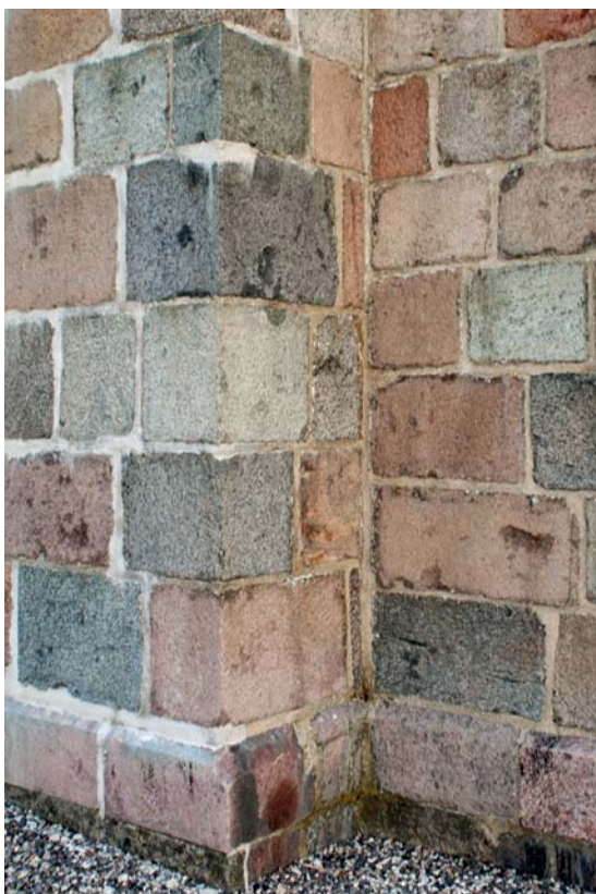
Fig. 17. Detalje af sammenføjesningen mellem kor og skib set fra sydøst (s. 1682). Foto Hugo Johannsen 2011. – Detail von Zusammenfügung zwischen Chor und Schiff aus Südosten.
