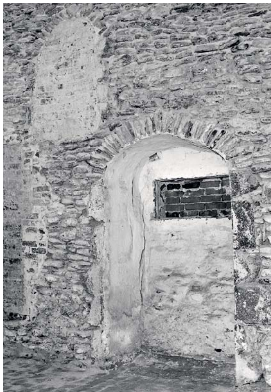
Fig. 21. Oprindelig dørniche og blændet vindue i skibets nordvæg under kirkens restaurering (s. 1684, 1686). Foto Egmont Lind 1963. – Ursprüngliche Türnische und verblendetes Fenster in Nordwand des Schiffes während der Restaurierung der Kirche.
