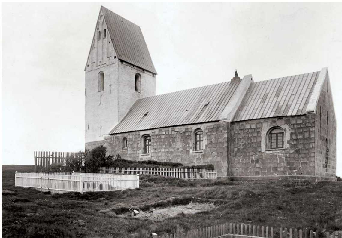
Fig. 24. Ydre set fra sydøst. Foto Chr. Axel Jensen 1904. – Äußeres aus Südosten.
